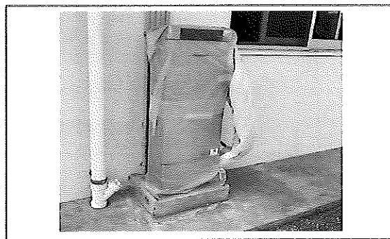
公共施設充放電設備設置
