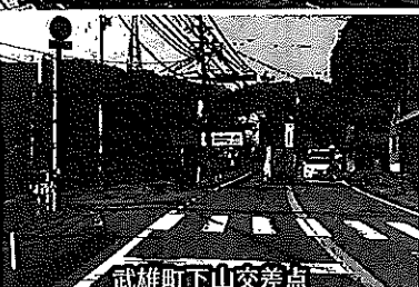
国道35号線S字カーブ新設道路
