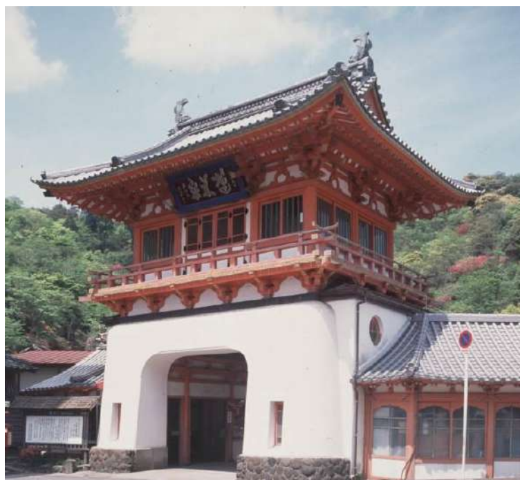
【武雄温泉楼門】
