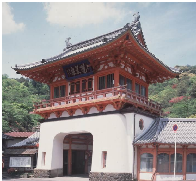
【武雄温泉楼門】
