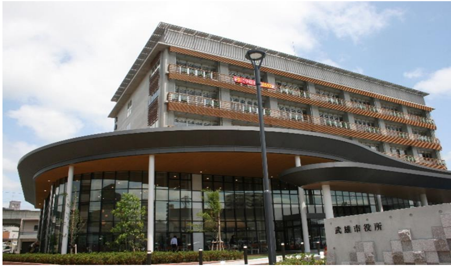
H30.4月 武雄市役所 新庁舎完成 / 5月 開庁
