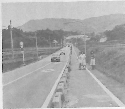
県道伊万里、武雄線に付設された歩道 ～十二神付近
