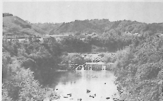
僧正井手 十二神橋上方の井堰で、その規模は縦20m 巾10m 高2m もある。別に水路をつくり、水を下黒髪に引く。
