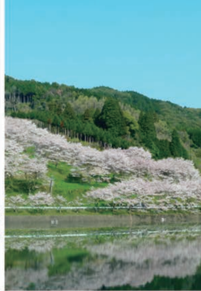
庭木ダム（西川登町）
