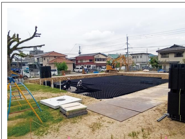
↑ 施工状況写真
