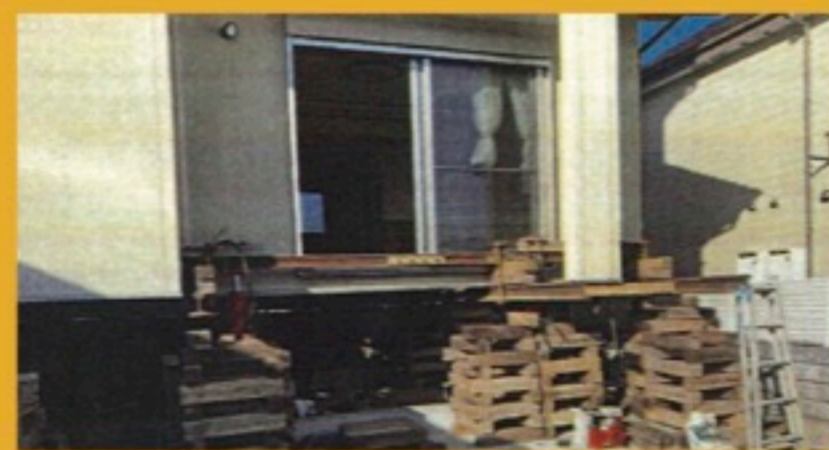
▲かさ上げ工事
